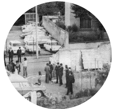
Photos prises durant l'occupation du terrain. Source : ATSF
