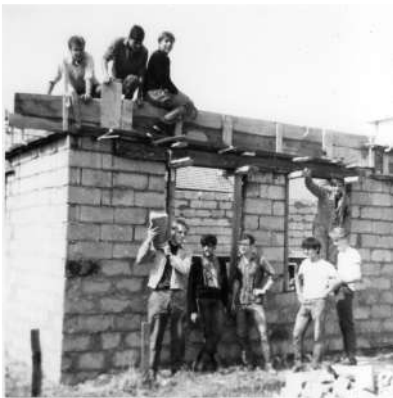
Durant la construction du club Source : Archives CJCL.
