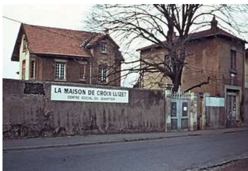
Figure A1. L'ancienne Maison de Croix-Luizet, Rue Courteline à Villeurbanne. Source : Maison de Croix-Luizet
